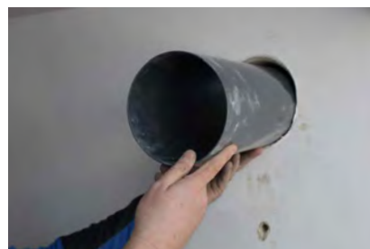
Wandedurchführung einsetzen
