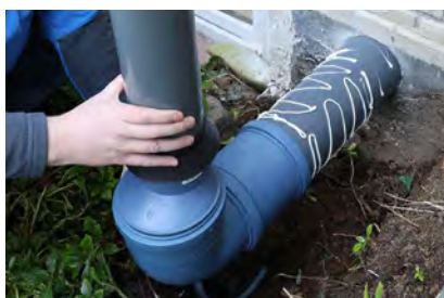
Wandedurchführung einsetzen und abdichten
