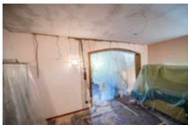
Sanieren und renovieren im bewohnten Zustand.
